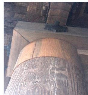
新旧の部材のつなぎ目
